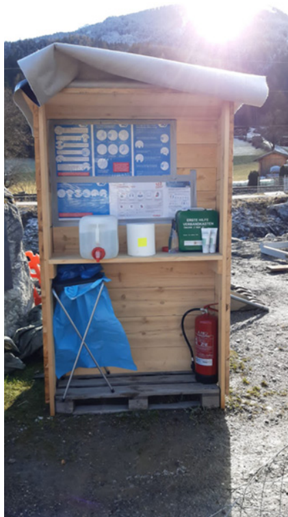
Hygienestützpunkt auf einer Baustelle
